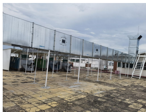
镭射废气处理设施
